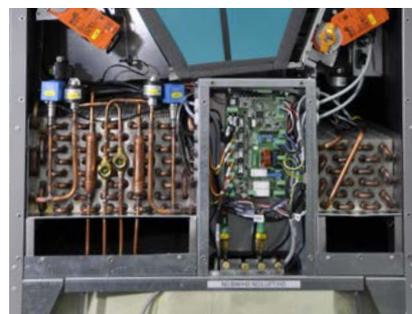
Abbildung.: Wärmetauscher und Kondensatwannen
