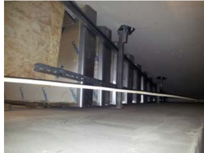
Sonder-Schalldämmkulissen in die Dachschräge eingebaut
