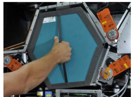
Figura: Intercambiador de calor a contracorriente
