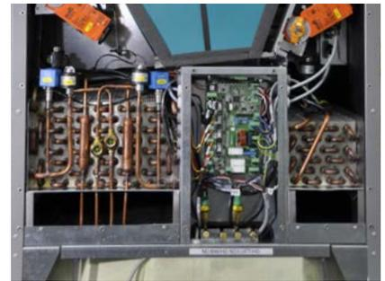
*Figura: Intercambiador de calor y cubetas de condensación*
