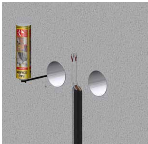
Mit Montageschaum einschäumen
